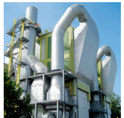
ЦЕМЕНТНЫЙ ЗАВОД, Германия КЛИНКЕРНЫЙ ХОЛОДИЛЬНИК
